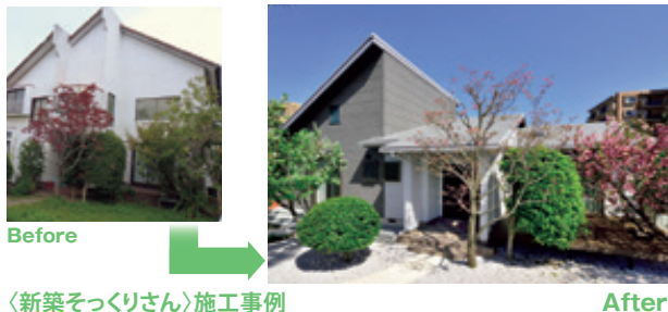
〈新築そっくりさん〉施工事例
